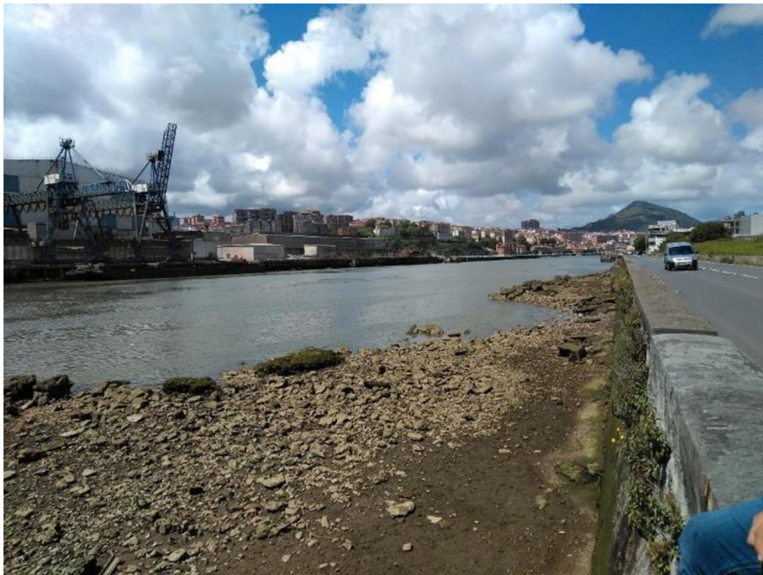
Imagen 17. Imagen de la Ría a la altura de la Dársena de Lamiako. Se trata de una imagen previa a la construcción del paseo peatonal que ya está presente en este tramo.
